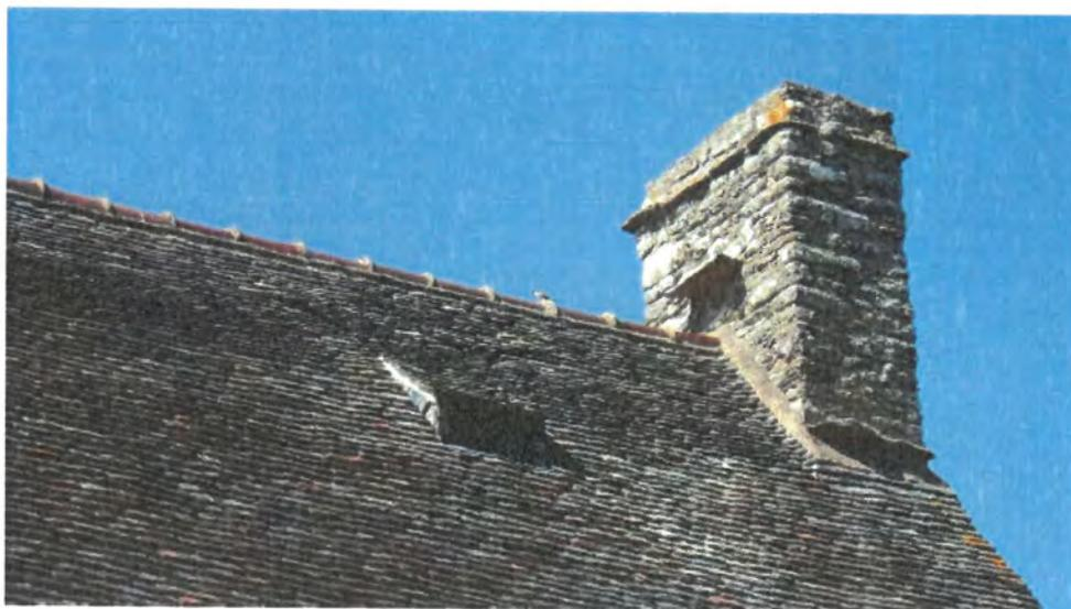
Figure 27. Chiroptière aménagée sur la toiture du grenier pour l'accès au caisson
