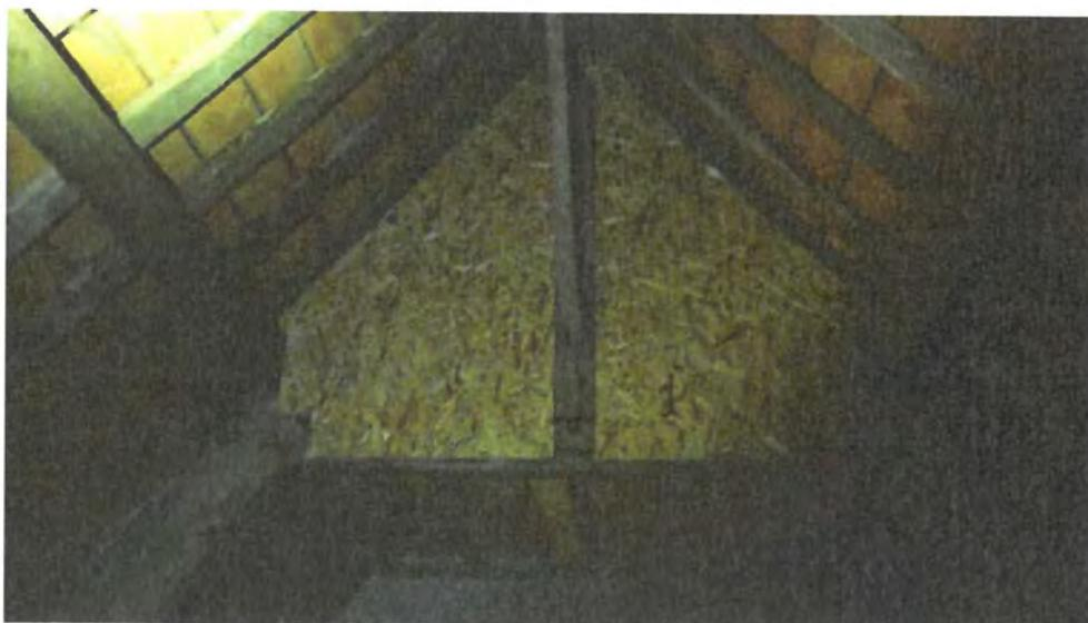
Figure 26. Caisson isolée du reste des combles du grenier, destiné à l'accueil des chauves-souris
